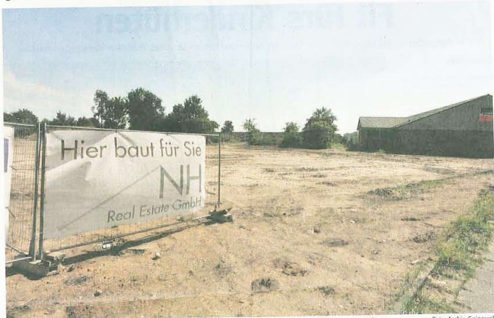
Sobald die Wohnungsbau-Förderungs-Anstalt grünes Licht gibt, kann Im Bonnefeld mit dem Bau der ersten sechs Häuser begonnen werden.
